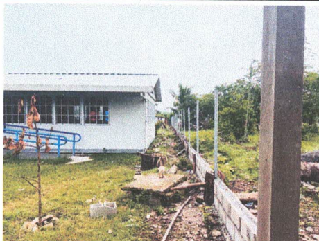
Foto 1: Reparación de tubo hg y malla galvanizada
