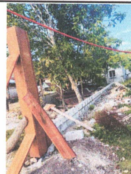
Foto 2: Reparación de tubo hg y malla galvanizada
