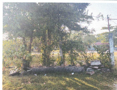
Foto 2: Reparación de tubo hg y malla galvanizada
