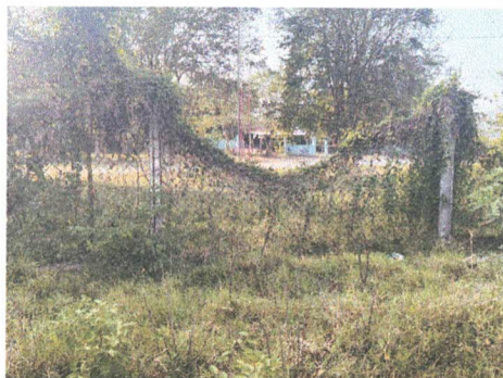
Foto 1: Reparación de tubo hg y malla galvanizada
