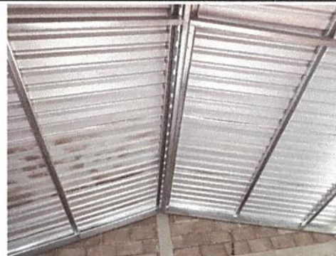
Foto 4: Instalación de estructura portante de metal
