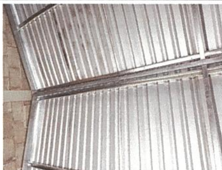
Foto 5: Instalación de lámina troquelada aluzinc
