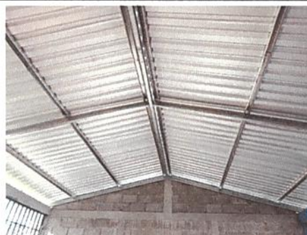
Foto 6: Desinstalación de estructura portante
