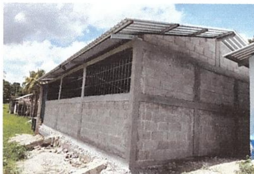
Foto 8: Mejoramiento de pared de block
