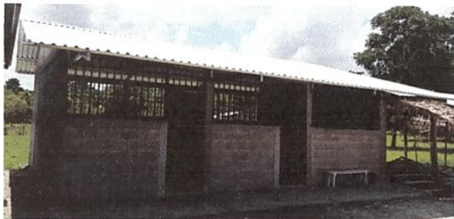
Foto 7: Desinstalación de lámina existente
