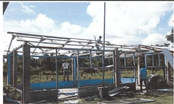
Foto 6: Desinstalación de estructura portante
