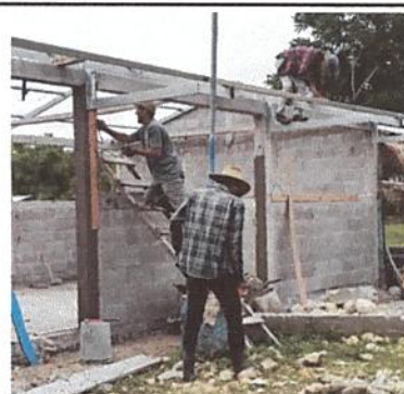
Foto 4: Instalación de estructura portante de metal
