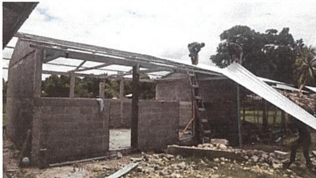
Foto 7: Desinstalación de lámina existente
