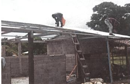
Foto 5: Instalación de lámina troquelada aluzinc
