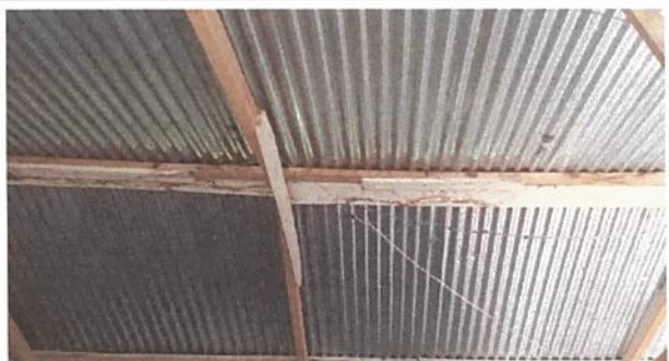
Foto 5: Instalación de lámina troquelada aluzinc
