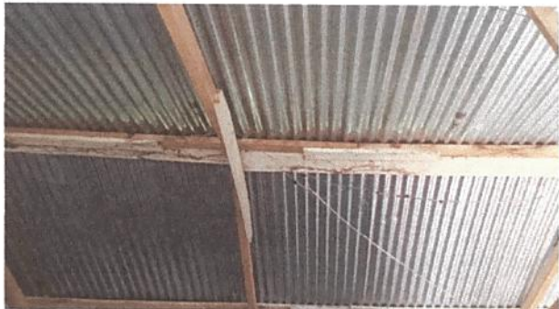
Foto 7: Desinstalación de lámina existente
