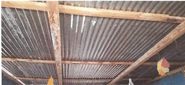
Foto 2: Sustrucción de estructura de soporte de madera, por metal
