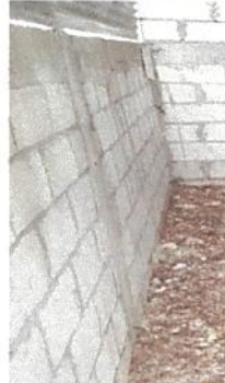
Foto 8: Mejoramiento de pared de block
