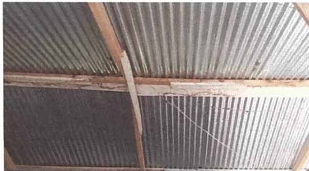
Foto 4: Instalación de estructura portante de metal
