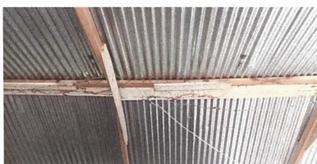
Foto 6: Desinstalación de estructura portante
