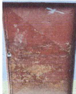
Foto 8 19.3 Fabricación e instalación de puertas de metal en módulos
