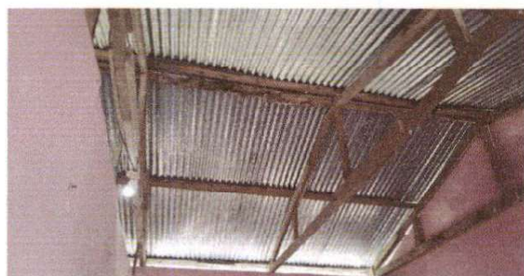
Foto 9: 19.7 Instalación de estructura portante de metal
