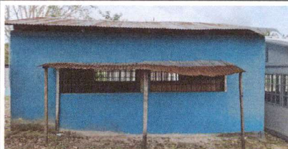
Foto 10: 19.8 Instalación de lamina troquelada alunzic calibre 26
