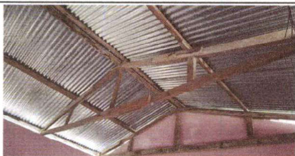
Foto 11: 19.9 Desinstalación de estructura portante
