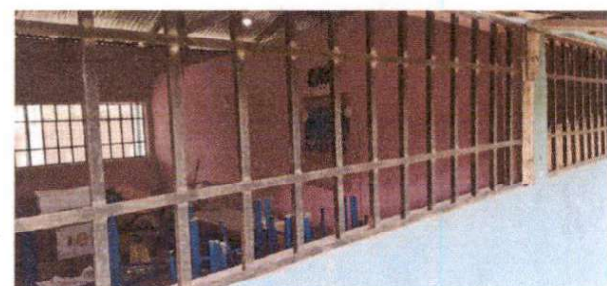
Foto 3: 5.7 Mantenimiento a balcones de metal
