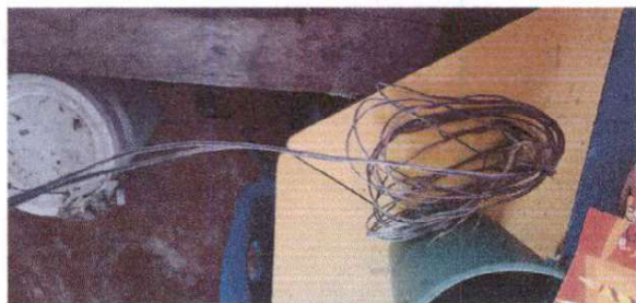
Foto 7: 17.11 Reparación de cableado electrico
