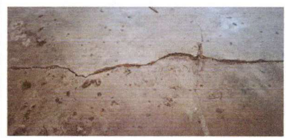
Foto 4: 6.6 Sustitución de piso de cemento liquido
