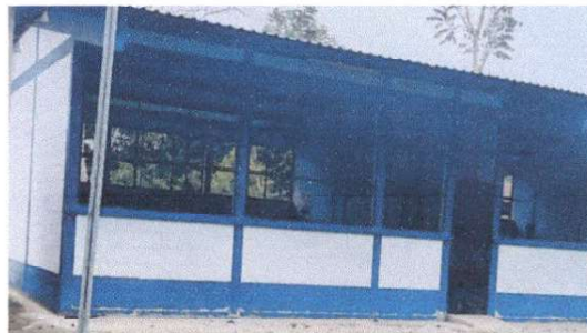
Foto 2: Pintura en muros exteriores e interiores
