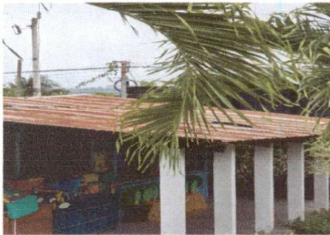
SUSTITUCIÓN DE LÁMINA POR LÁMINA TROQUELADA ALUZINC 26
