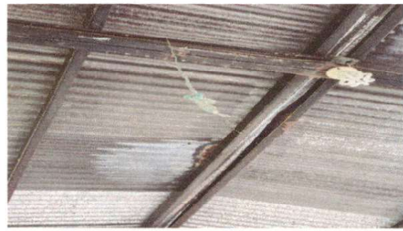
MANTENIMIENTO A ESTRUCTURA DE SOPORTE DE METAL
