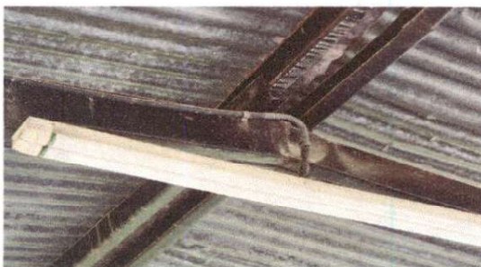
INSTALACION DE LÁMINA TROQUELADA ALUZINC CALIBRE 26
