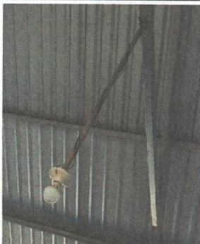
Foto 3: Reparación de cableado eléctrico
