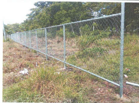
Foto 2: Reparación de tubo hg y malla galvanizada
