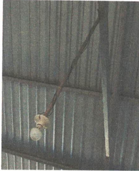
Foto 3: Reparación de cableado eléctrico
