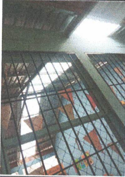
Foto 1: Sustrucción de lámina, por lámina troquelada aluzinc calibre 26
