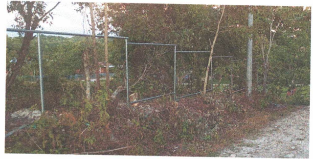
Foto 2: Reparación de tubo hg y malla galvanizada
