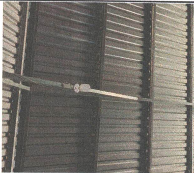
Foto 3: Reparación de cableado eléctrico
