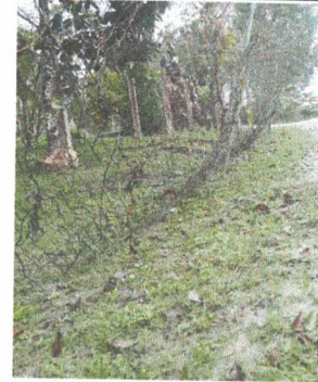
Foto 2: Reparación de tubo hg y malla galvanizada
