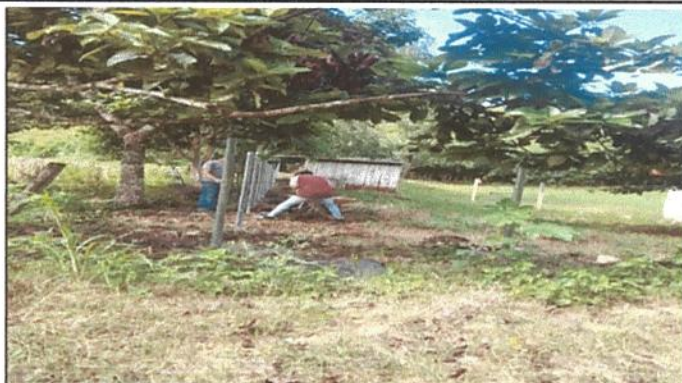
Foto 2. Instalacion de postes de tubo galvanizado y malla galvanizada
