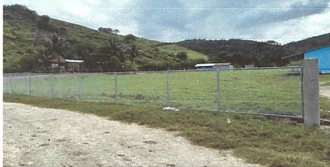
Foto 1. Sustrucion e instalacion de postes de tubo galvanizado y malla galvanizada (cerco de alambre de puas en mal estado)
