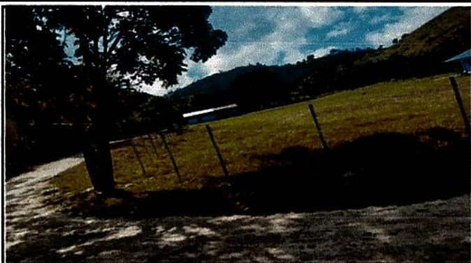
Foto 1. Sustrucion e instalacion de postes de tubo galvanizado y malla galvanizada (cerco de alambre de puas en mal estado)
