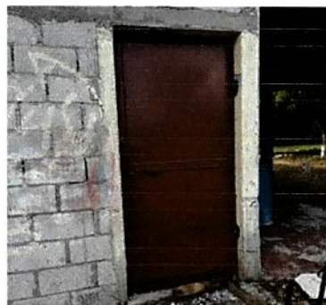
Foto 4: Sustitucion de puerta
