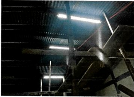
Foto 7: Sustrucion de lamparas tipo led
