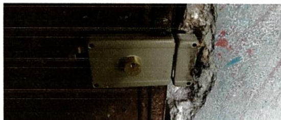
Foto 5: Sustitucion de chapa
