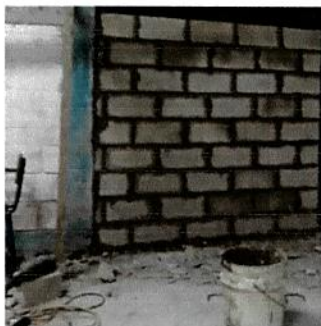
Foto 1: Reparacion de muro perimetral
