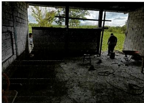
Foto 1: Reparacion de muro perimetral
