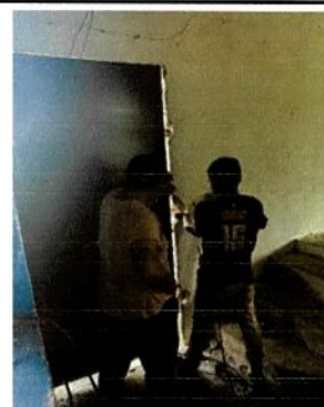
Foto 4: Sustitucion de puerta
