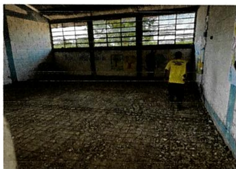
Foto 3: Sustitucion de piso de cemento liquido
