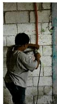
Foto 6: Sustitucion de ducto electrico + accesorios
