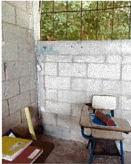
Foto 1: Reparacion de muro perimetral
