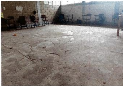
Foto 3: Sustitucion de piso de cemento liquido
