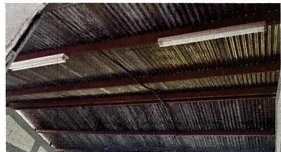
Foto 6: Sustitucion de ducto electrico + accesorios
