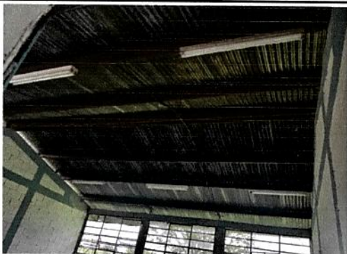
Foto 7: Sustitucion de lamparas tipo led
