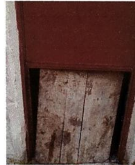
Foto 4: Sustitucion de puerta
