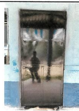
4.1 MANTENIMIENTO A ESTRUCTURA
