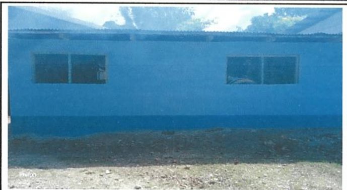
9.1 PINTURA EN MUROS EXTERIORES E INTERIORES
