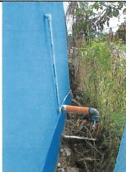
19.21 INSTALACION DE TUBERIA PARA AGUA POTABLE
