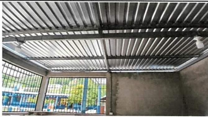
17.11 REPARACION DE CABLEADO ELECTRICO
