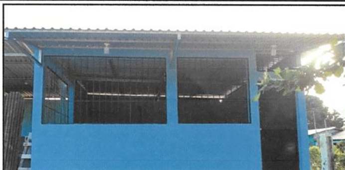
CUBIERTA DE LAMINA Y ESTRUCTURA DE TECHO
