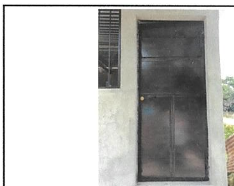
19.3 FABRICACION E INSTALACION DE PUERTAS DE METAL EN MODULO
