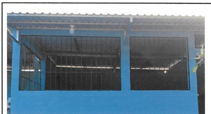
19.2 FABRICACION E INSTALACION DE BALCONES DE HIERRO EN VENTANA
