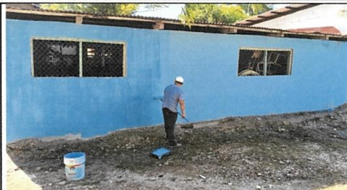
9.1 PINTURA EN MUROS EXTERIORES E INTERIORES
