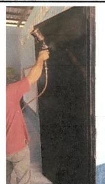
4.1 MANTENIMIENTO A ESTRUCTURA
