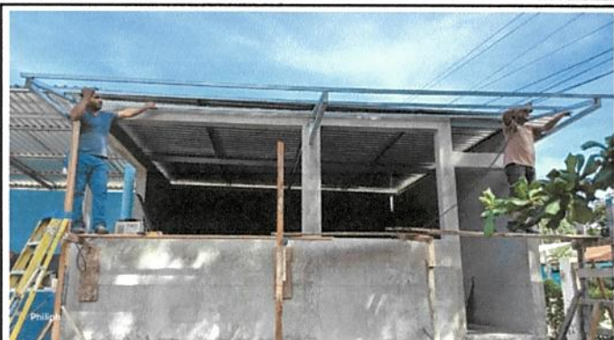
CUBIERTA DE LAMINA Y ESTRUCTURA DE TECHO
