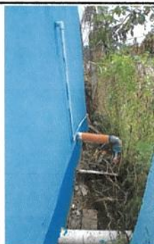
19.21 INSTALACION DE TUBERIA PARA AGUA POTABLE
