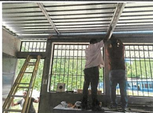
17.11 REPARACION DE CABLEADO ELECTRICO
