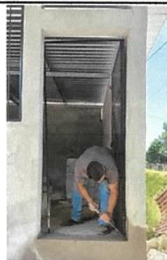
19.3 FABRICACION E INSTALACION DE PUERTAS DE METAL EN MODULO
