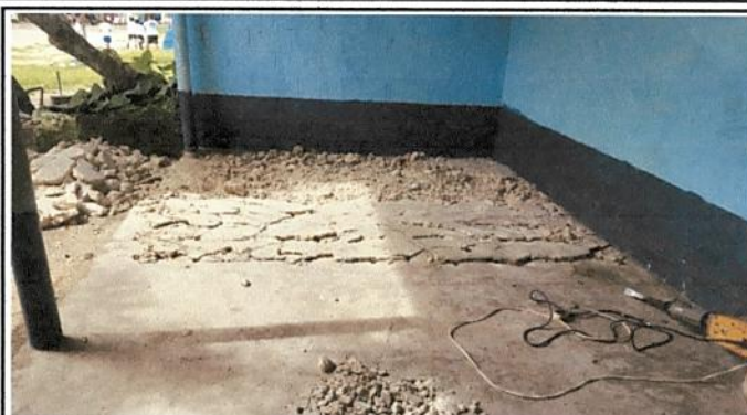
6.5 SUSTITUCION DE PISO DE TORTA DE CEMENTO
