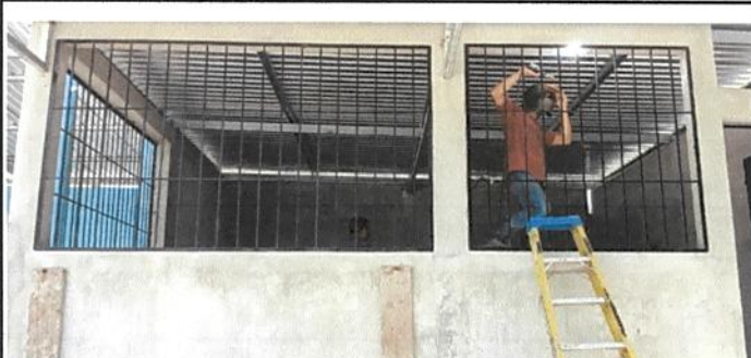
19.2 FABRICACION E INSTALACION DE BALCONES DE HIERRO EN VENTANA
