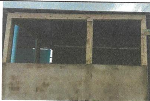
19.2 FABRICACION E INSTALACION DE BALCONES DE HIERRO EN VENTANA
