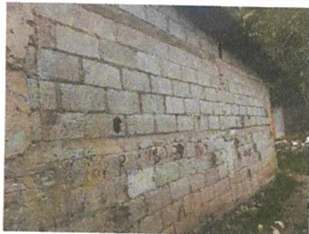
2.1.1 REPELLO EN MURO
