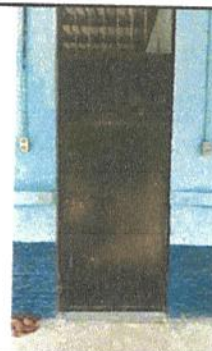
4.1 MANTENIMIENTO A ESTRUCTURA
