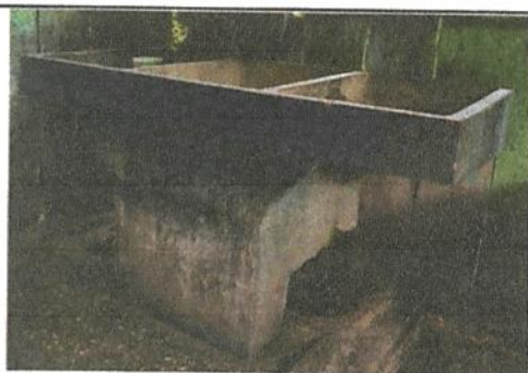
20.1 SUSTITUCION DE PILA DE CEMENTO DE DOS LAVADEROS
