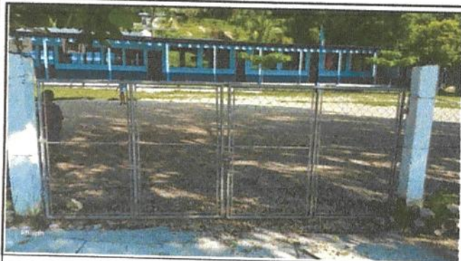
SUSTITUCION DE PORTONES DE INGRESO
