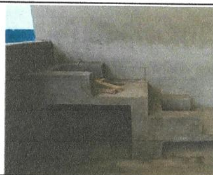
20.2 SUSTITUCION DE ESTUFA RURAL COMPLETA
