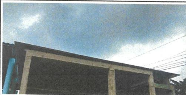
CUBIERTA DE LAMINA Y ESTRUCTURA DE TECHO
