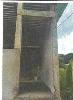
19.3 FABRICACION E INSTALACION DE PUERTAS DE METAL EN MODULO
