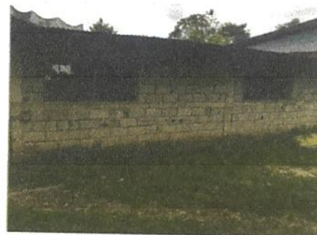
9.1 PINTURA EN MUROS EXTERIORES E INTERIORES
