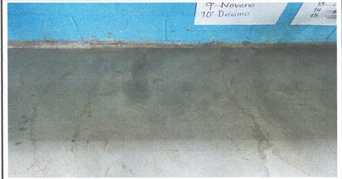
Foto 2: Reparación de piso de cemento liquido.
