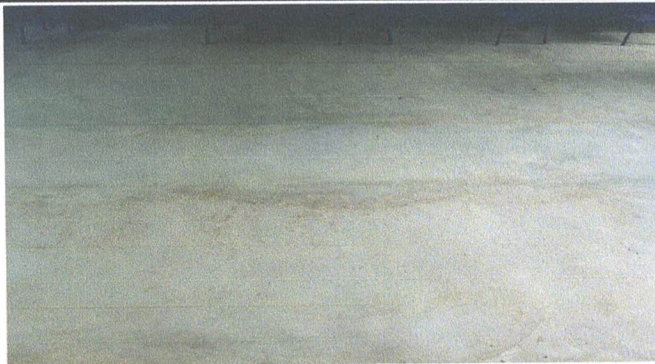
Foto 3: Reparación de piso de cemento liquido.
