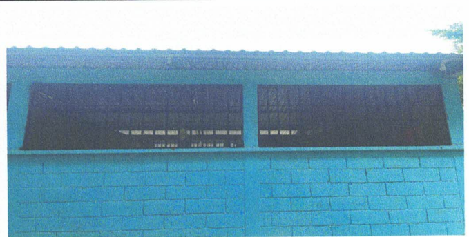
Foto 6: Sustitución de Estructura en Ventana.
