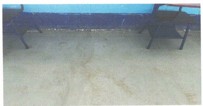
Foto 4: Reparación de piso de cemento liquido.
