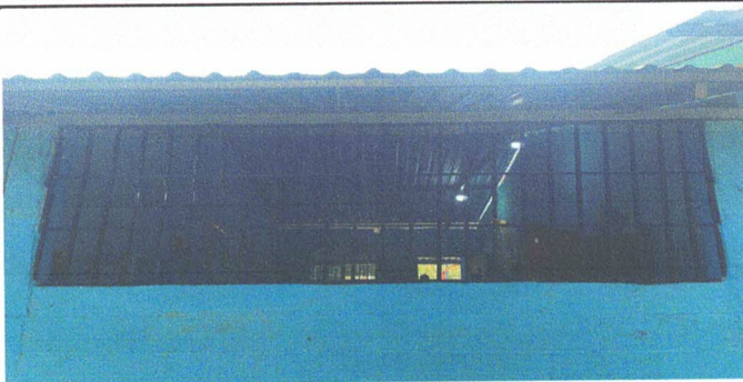
Foto 5: Sustitución de Estructura en ventana.
