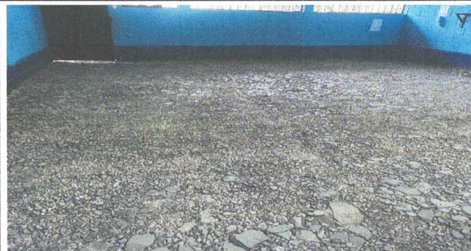
Foto 2: Reparación de piso de cemento liquido.
