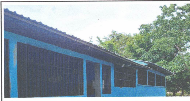
Foto 6: Sustitución de Estructura en ventana
