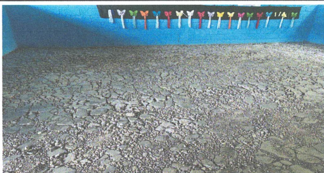
Foto 1: Reparación de piso de cemento liquido.
