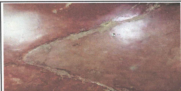
Foto 1: Reparación de piso de cemento liquido
