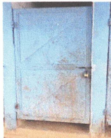
Foto 8: Reparacion de puerta de baño
