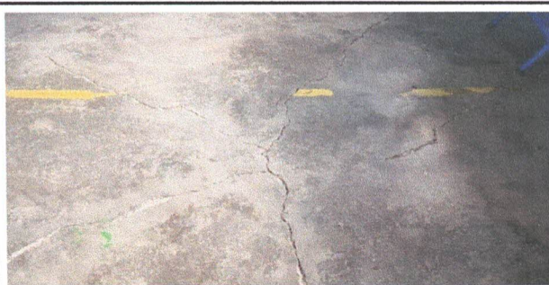
Foto 2: Reparación de piso de cemento liquido
