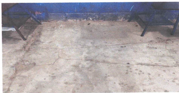
Foto 3: Reparación de piso de cemento liquido
