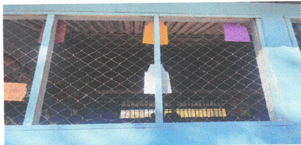
Foto 5: Sustitución de Estructura en ventana
