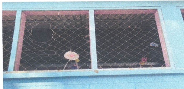
Foto 6: Sustitución de Estructura en Ventana
