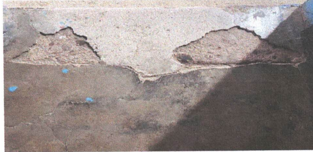
Foto 4: Reparación de piso de cemento liquido
