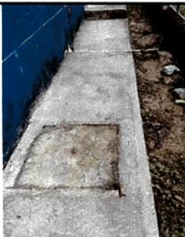
Foto 6: Reparación banqueta de concreto.
