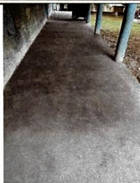
Foto 2: Reparación de torta de concreto
