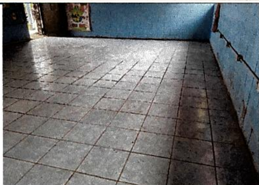
Foto 1: Reparación de piso de torta de concreto, suministro de piso ceramico
