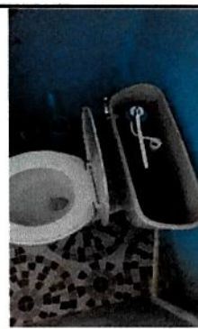
Foto 4: Sustitución de accesorios inodoro (contra llave, tubo de abasto y tanque)
