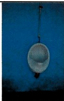
Foto 5: Sustitución de llave en mingitorio
