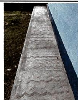
Foto 6: Reparación banqueta de concreto.
