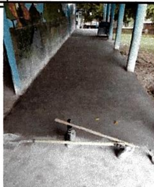
Foto 2: Reparación de torta de concreto
