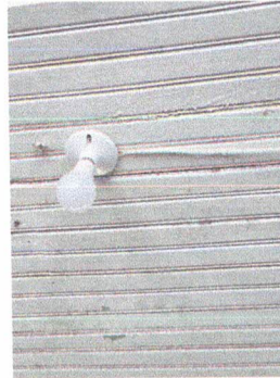
Foto 4: Sustitución de Plafonera
