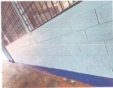
Foto 3: Pintura en muros exteriores e interiores
