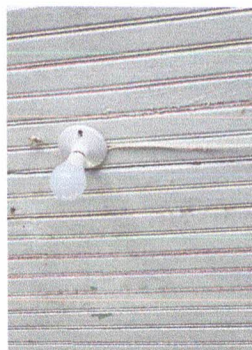
Foto 4: Sustitución de Plafonera
