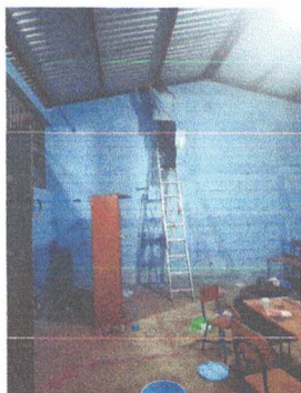
Foto 3: Pintura en muros exteriores e interiores
