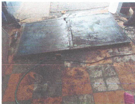
Foto 1: Mantenimiento a estructura (lijado, cambio de tubo, cepillado, sujeciones, aplicación de pintura)
