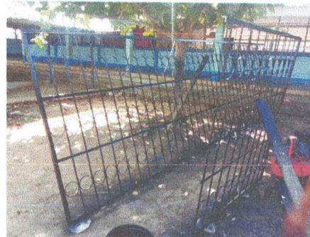
Foto 2: Mantenimiento a balcones de metal
