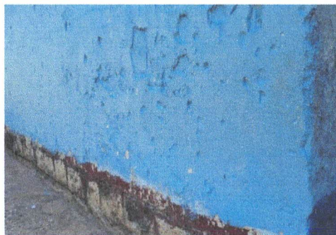
Foto 6: Repello en muro
