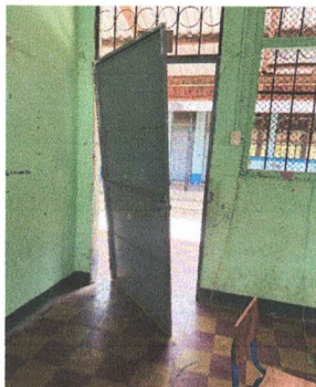
Foto 1: Mantenimiento a estructura (lijado, cambio de tubo, cepillado, sujeciones, aplicación de pintura)
