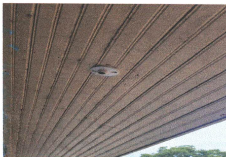
Foto 4: Sustitución de Plafonera
