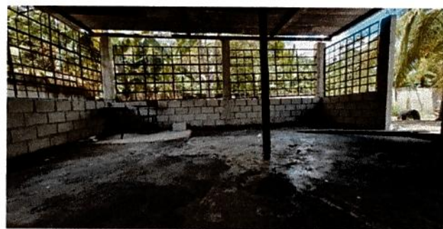
Foto 9: Reparación de muro perimetral de block.
