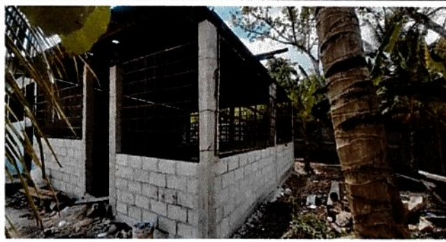
Foto 4: Sustrucción de balcones de metal
