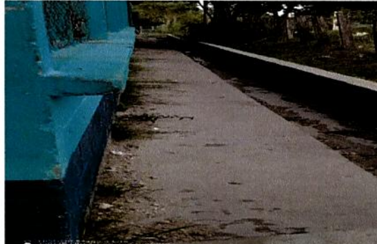
Foto 8: Reparación de muro de contención
