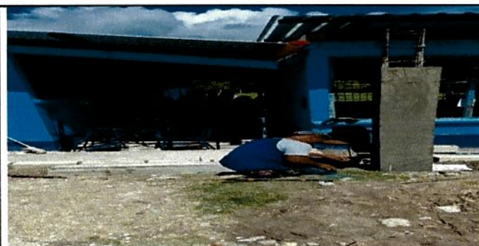
Foto 6: Reparación de cuneta de concreto
