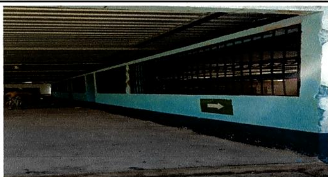
Foto 1: Sustrucción de balcón de metal
