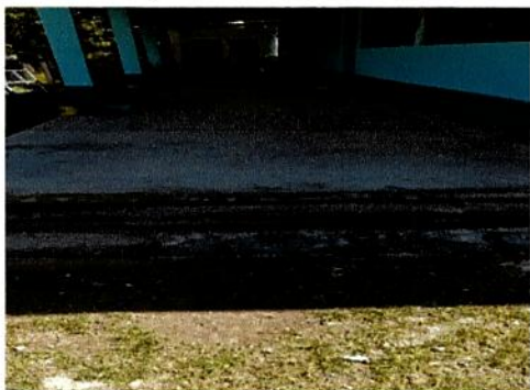
Foto 7: Reparación de Torta de concreto
