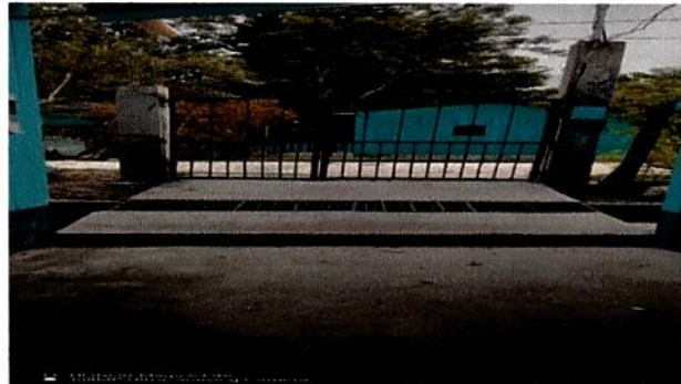
Foto 10: Fabricación e instalación de porton de metal
