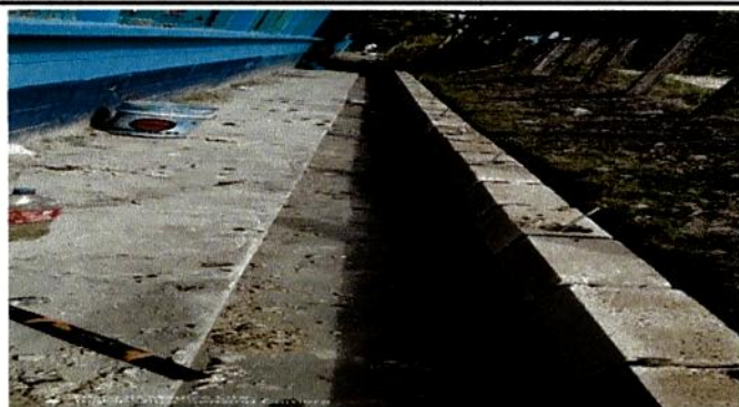
Foto 8: Reparación de muro de contención
