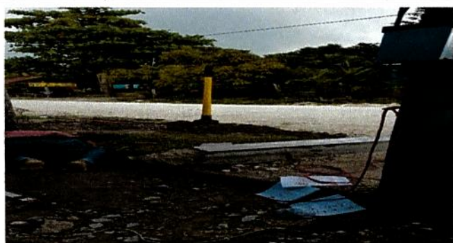
Foto 9: Sustitución de poste de concreto
