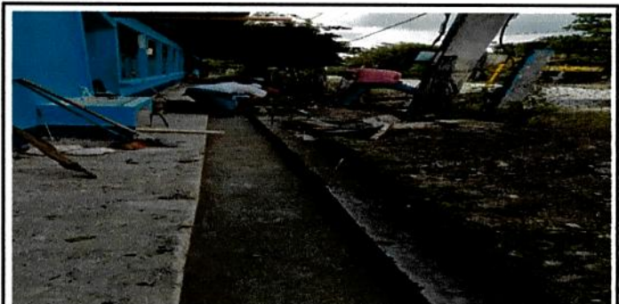
Foto 6: Reparación de cuneta de concreto
