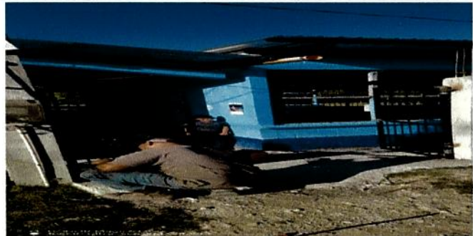
Foto 10: Fabricación e instalación de porton de metal
