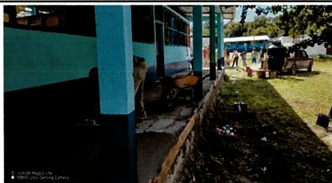
Foto 7: Reparación de Torta de concreto
