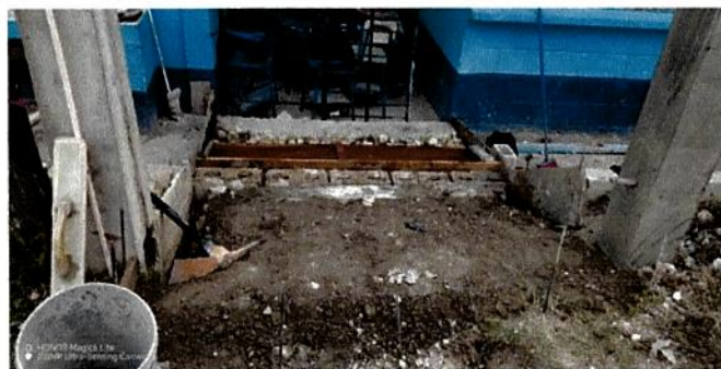
Foto 11: Reparación de torta de concreto
