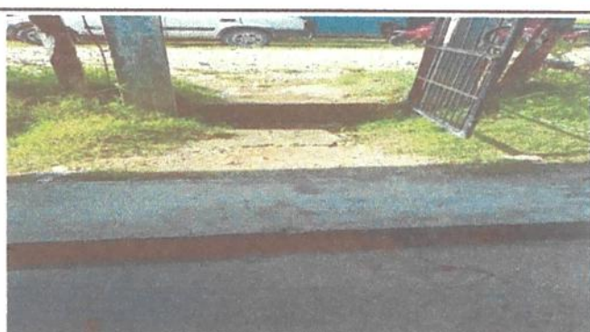
10. Fabricación e instalación de porton de metal.
