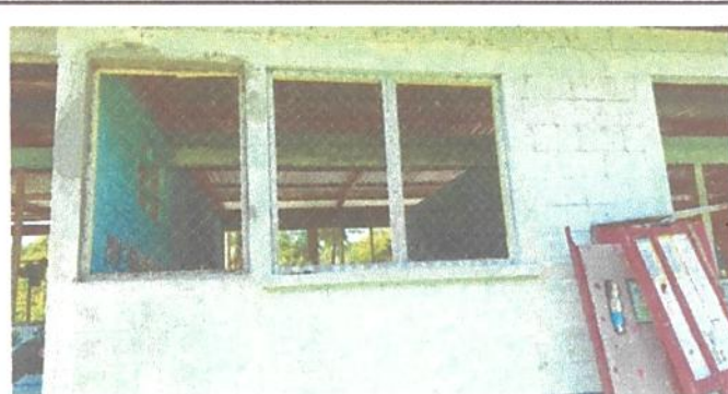
Foto 4: Sustitución de Balcones de metal
