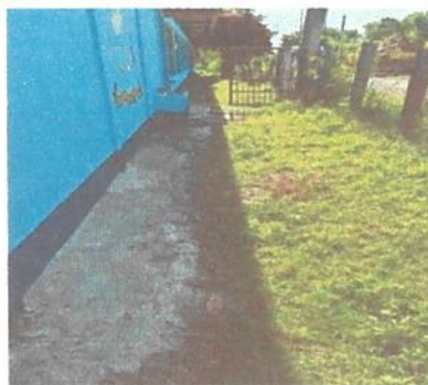
Foto 6: Reparación de cuneta de concreto
