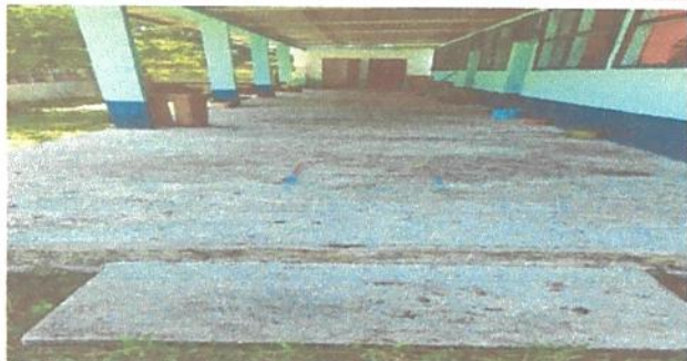
Foto 7: Reparación de torta de concreto
