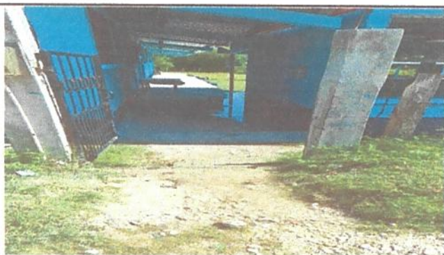
9. Sustitución de poste de concreto.
