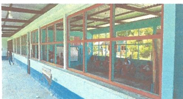
Foto 2: Sustitución de balcones de metal
