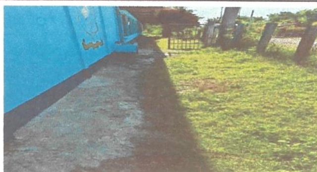
Foto 8: Reparación de muro de contención
