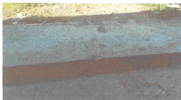
11. Reparación de torta de concreto.
