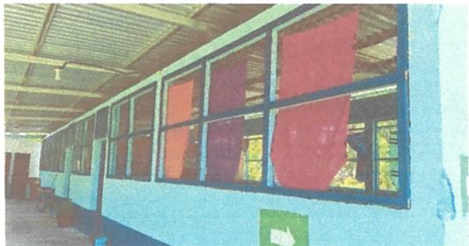
Foto 1: Sustitución de balcones de metal
