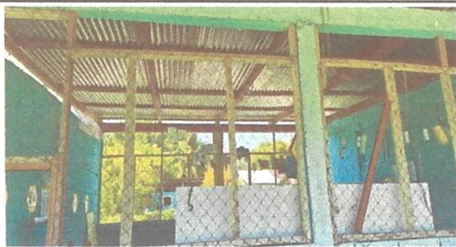
Foto 3: Sustitución de Balcones de metal
