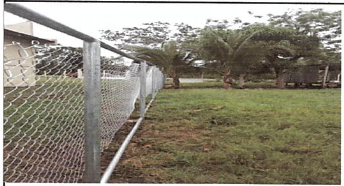
Foto 2: Reparación tubo hg y malla galvanizada
