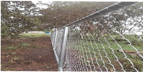
Foto 3: Reparación de tubo hg y malla galvanizada
