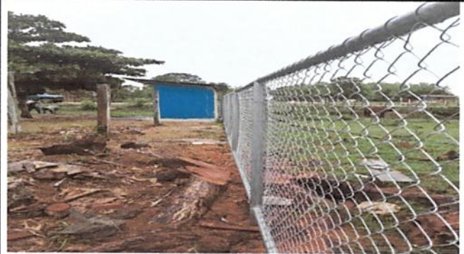
Foto 4: Reparación de tubo hg y malla galvanizada
