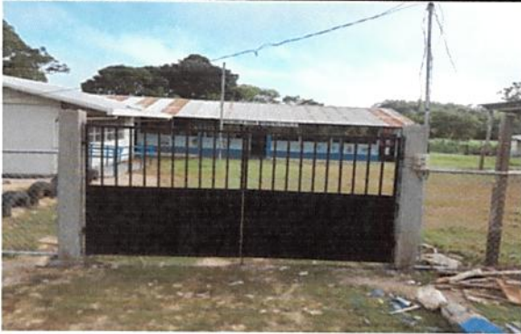
Foto 1: Sustitución de Portón de Metal
