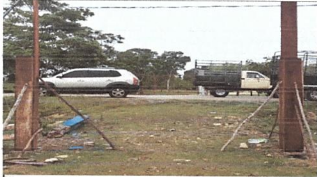
Foto 1: Sustitución de Portón de Metal
