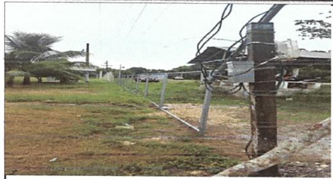
Foto 2: Reparación tubo hg y malla galvanizada
