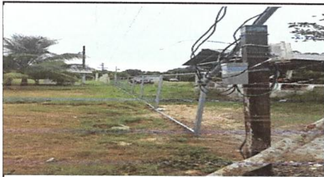
Foto 3: Reparación de tubo hg y malla galvanizada
