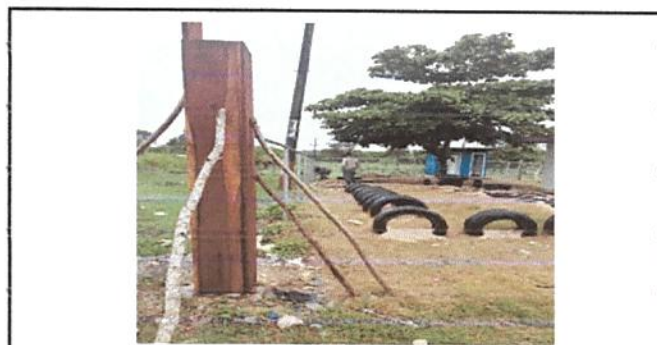
Foto 4: Reparación de tubo hg y malla galvanizada
