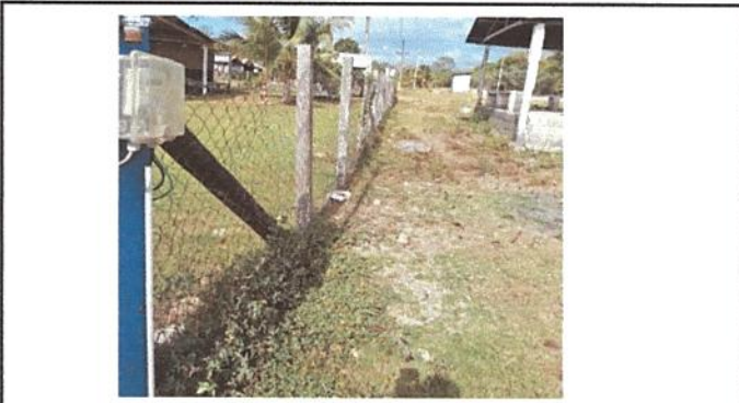
Foto 2: Reparación de tubo hg y malla galvanizada "A"
