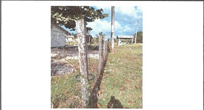
Foto 3: Reparación de tubo hg y malla galvanizada "B"
