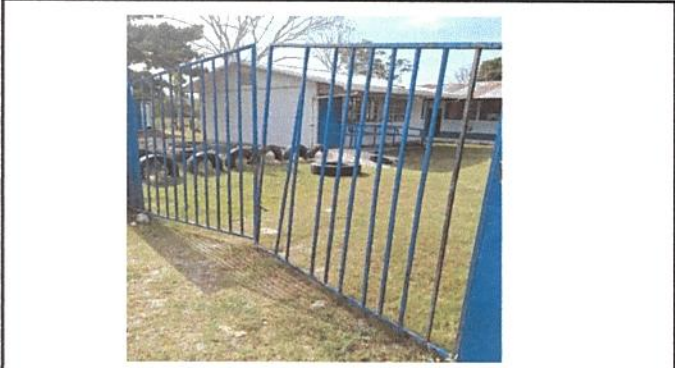
Foto 1: Sustrución de Porton de metal
