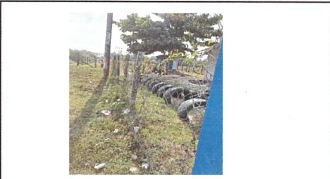
Foto 4: Reparación de tubo hg y malla galvanizada "C"
