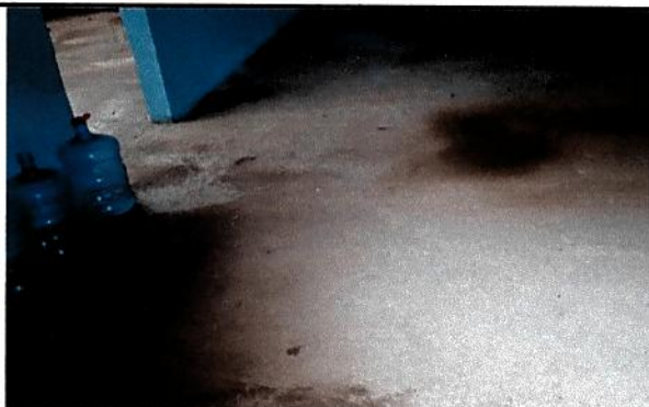
Foto 3: Sustrucción de piso de cemento liquido
