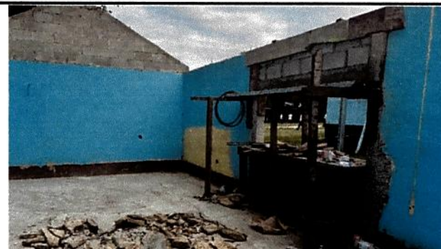
Foto 6: Reparación de muro perimetral de block con tubo hg y malla galvanizada, soleras intermedias y columnas en cocina
