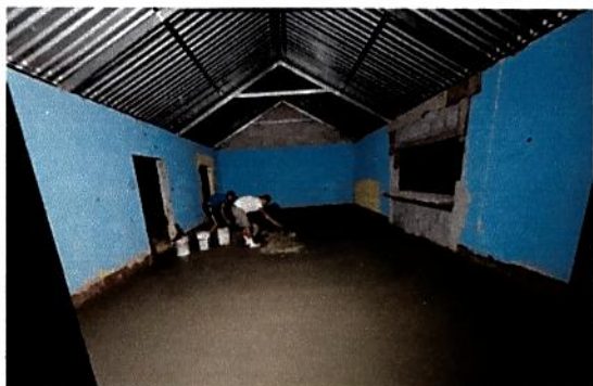
Foto 3: Sustrucción de piso de cemento liquido
