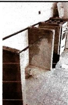
Foto 8: Repello en muro de mueble de cocina
