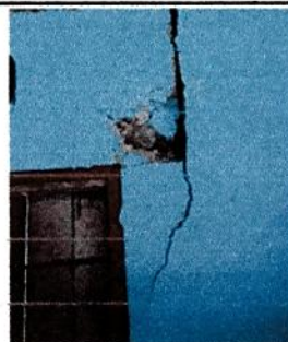
Foto 6: Reparación de muro perimetral de block con tubo hg y malla galvanizada, soleras intermedias y columnas en cocina
