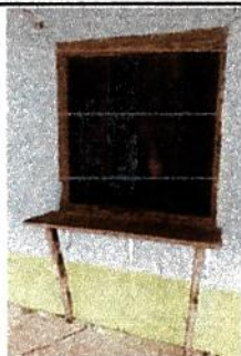
Foto 5: Fabricación e instalación de ventana-balcon de metal
