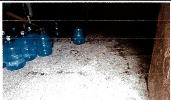
Foto 3: Sustitución de piso de cemento líquido
