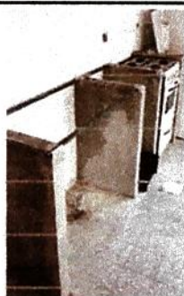
Foto 7: Reparación de azulejo en muebles de cocina
