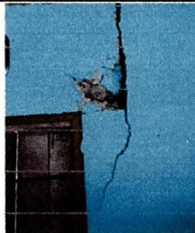
Foto 4: Reparación de muro perimetral de block en cocina
