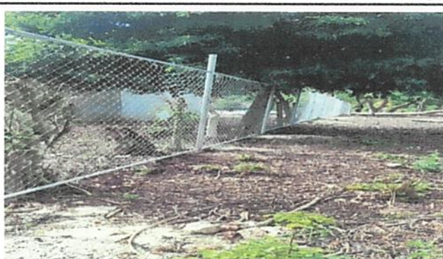
COLOCACION DE MALLA CON TUBO, LADO QUE COLINDA CON IGLESIA.
