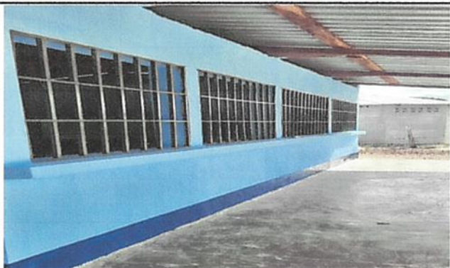
INSTALACION DE BALCONES
