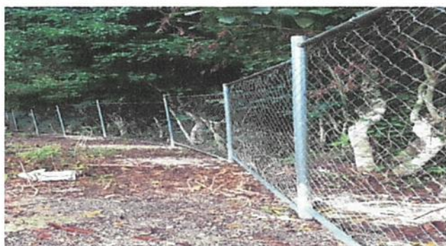
COLOCACION DE MALLA CON TUBO, LADO QUE COLINDA CON ARROLLO
