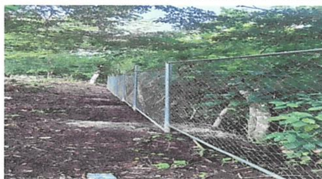
COLOCACION DE TUBO Y MALLA LADO QUE COLINDA CON CALLEJON
