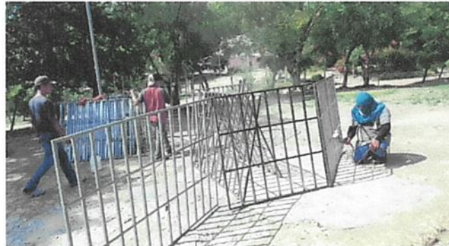
PINTANDO BALCONES, PARA SU INSTALACION
