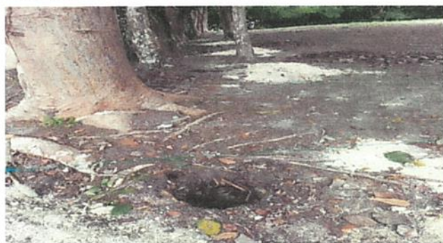
ELABORACION DE LOS HOYOS
