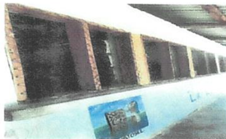
Foto 2. sustitucion de ventanas de malla por balcones de metal
