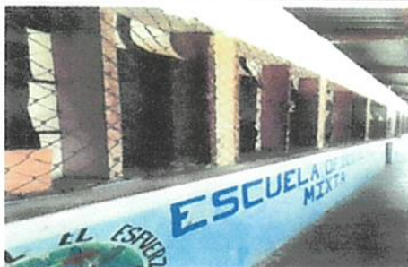
Foto 1. Sustitución de ventanas de malla por balcones de metal
