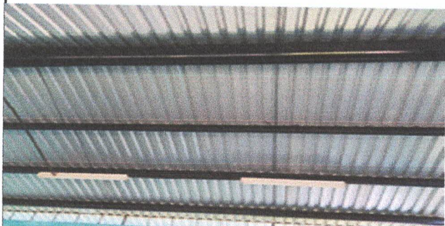
Foto 1: Mantenimiento a estructura de soporte de metal
