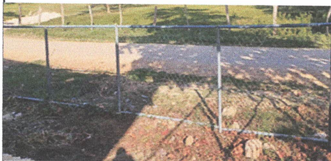
Foto 4: Reparación de tubo hg y malla galvanizada
