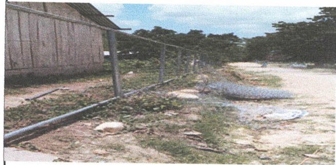
Foto 4: Reparación de tubo hg y malla galvanizada
