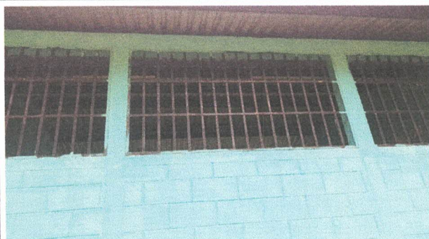
Foto 3: Pintura de muros exteriores
