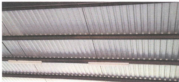
Foto 1: Mantenimiento a estructura de soporte de metal
