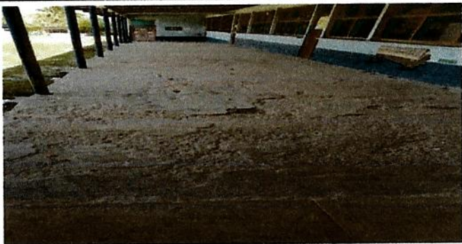
Foto 4: Sustitución de piso
