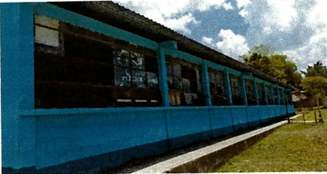
Foto 1: Sustitución de Ventanales
