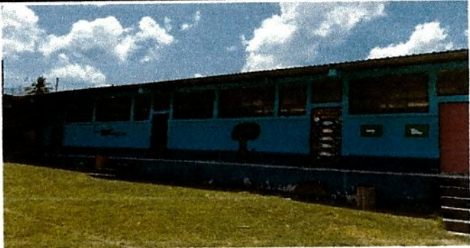
Foto 2: Sustitución de Ventanales
