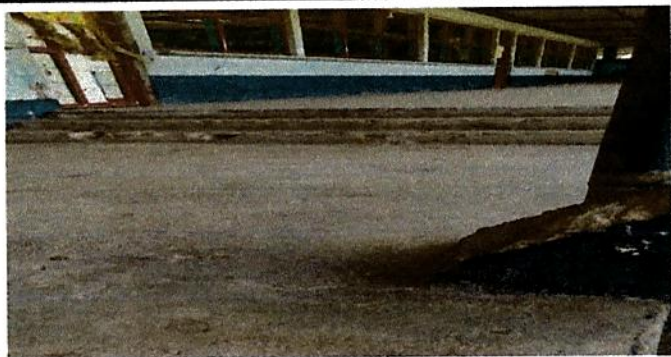
Foto 3: Sustitución de gradas de acceso
