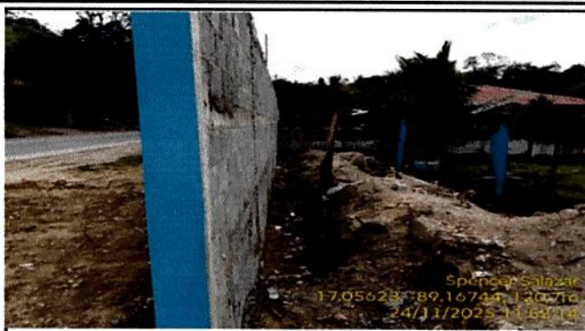
Foto 2: Reparacion de muro de contencion, block, soleras intermedia y columnas.
