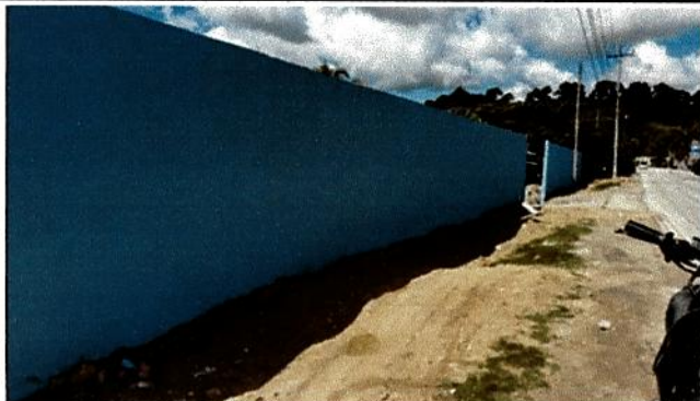
Foto 1: Reparacion de muro perimetral de block
