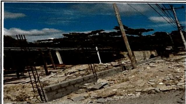
Foto 2: Reparación de muro de contención, block, soleras intermedia y columnas.
