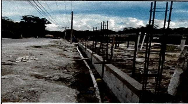
Foto. 1: Reparación de muro perimetral de block
