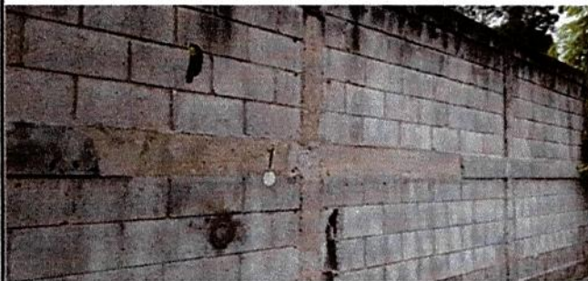
Foto 2: Reparación de muro de contención, block, Soleras intermedias y columnas
