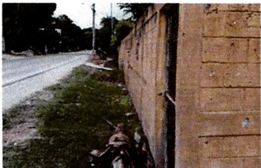
Foto 1: Reparación de muro perimetral de block.
