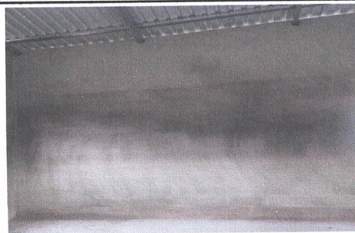
Foto 12: Reparación de Repello en muros
