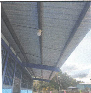
Foto 9: Reparación de cableado eléctrico
