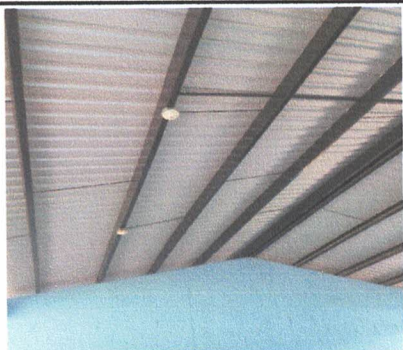
Foto 7: Sustitución de plafoneras
