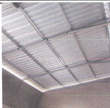
Foto 2: Mantenimiento a estructura de soporte de metal
