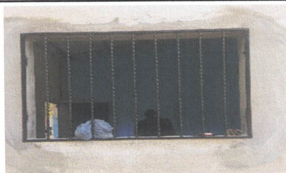
Foto 10: Fabricación e instalación de ventana-balcón de metal
