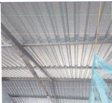
Foto 3: sustitución de estructuras de soporte de madera por metal.
