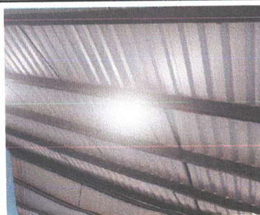
Foto 6: Sustitución de focos ahorradores
