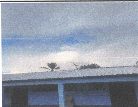
Foto 1: Sustitución de lámina, por lámina troquelada aluzinc calibre 26
