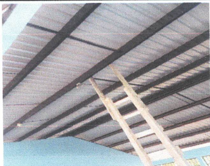
Foto 7: Sustrución de plafoneras
