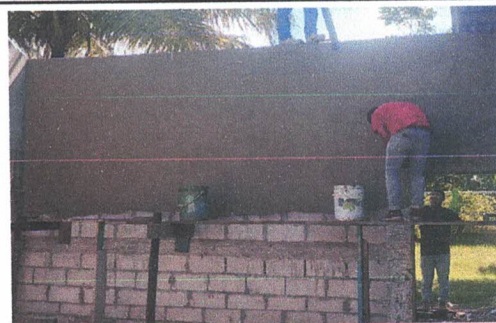
Foto 12. Reparación de Repello en muros
