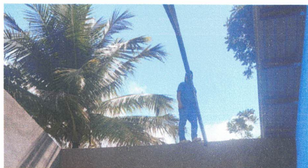
Foto 2: Mantenimiento a estructura de soporte de metal
