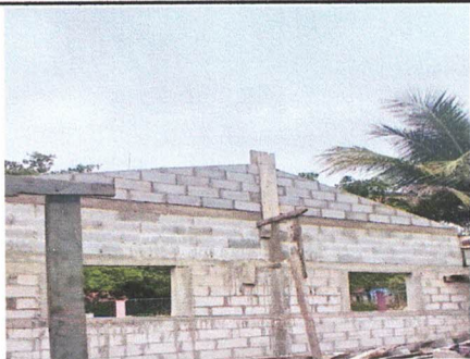
Foto 5: Reparación de muro perimetral de block en módulo
