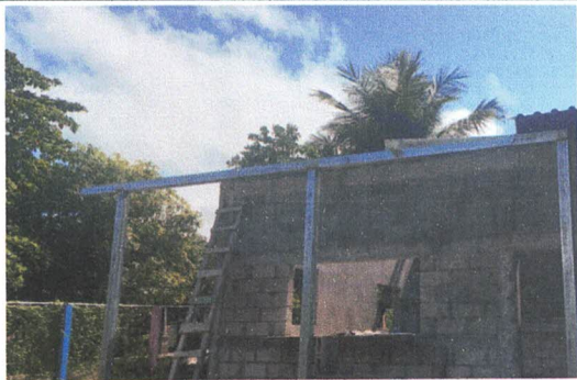
Foto 3: sustitución de estructuras de soporte de madera por metal.
