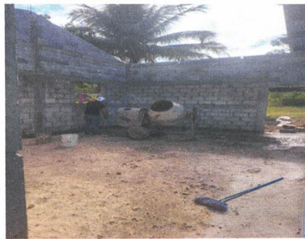
Foto 4: sustitución de piso de cemento líquido
