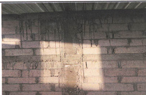
Foto 5: Reparación de muro perimetral de block en módulo
