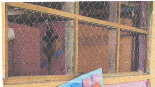
Foto 10: Fabricación e instalación de ventana-balcón de metal
