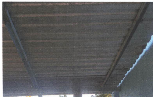
Foto 2: Mantenimiento a estructura de soporte de metal
