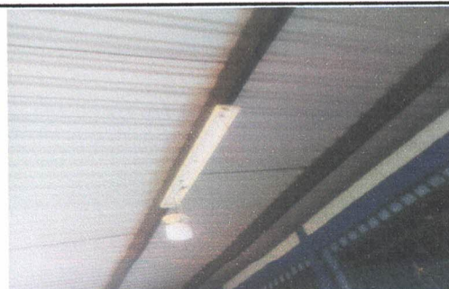
Foto 6: Sustitución de focos ahorradores
