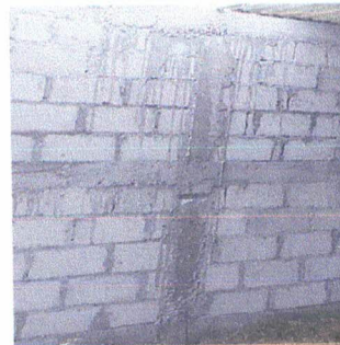
Foto 12. Reparación de Repello en muros
