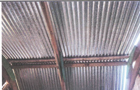
Foto 3: sustitución de estructuras de soporte de madera por metal.
